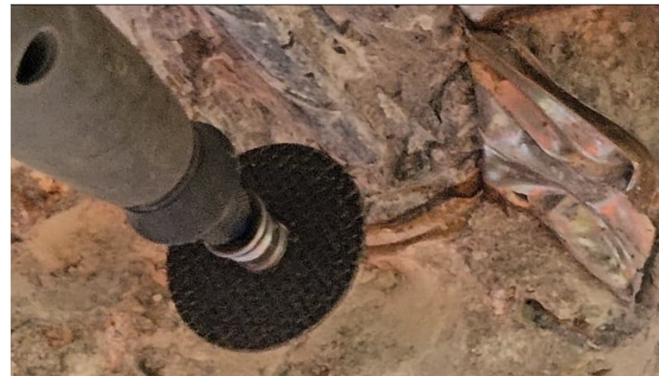
Entnahme Spanndrähte (PLAY▶)
