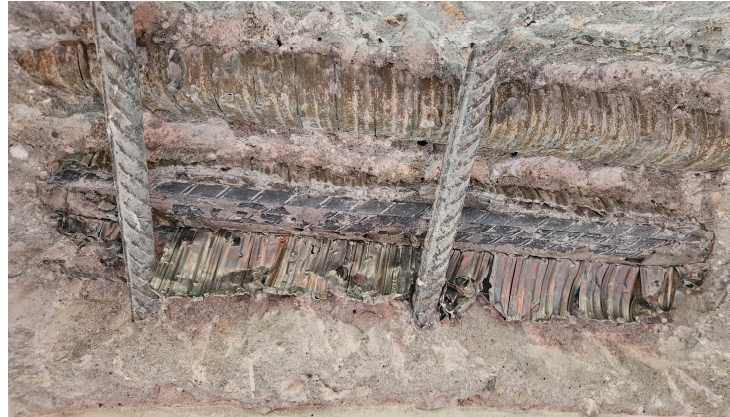
Entnahme Spanndrähte (PLAY▶)
