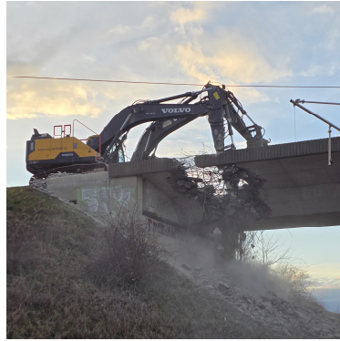
Die Spannbetonbrücke, Baujahr 1979, wurde in nur vier Tagen abgerissen
