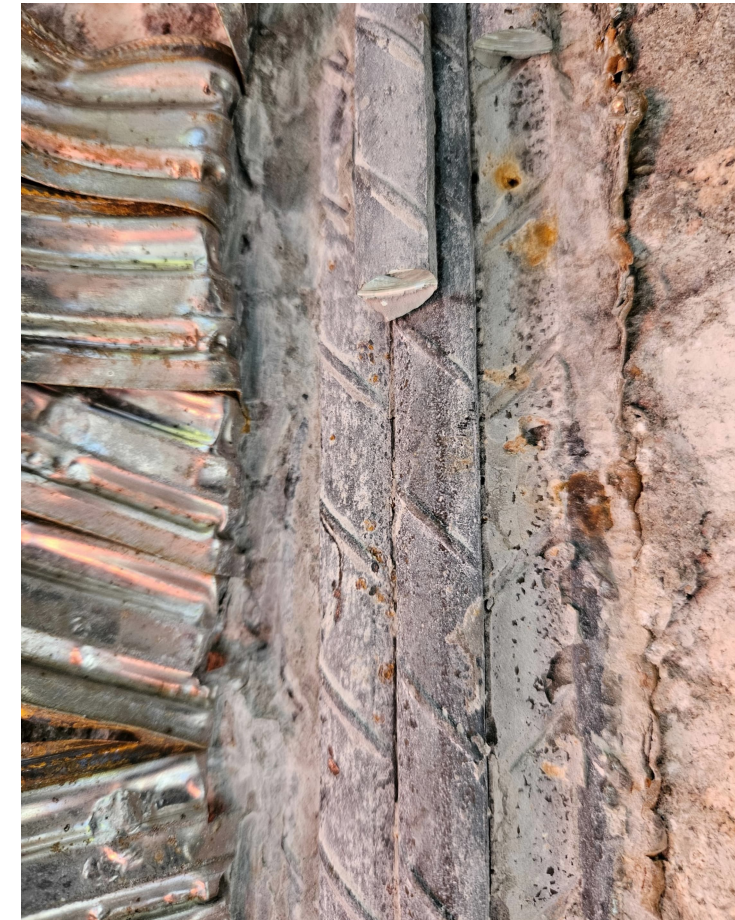
Durchtrennte Spanndrähte
