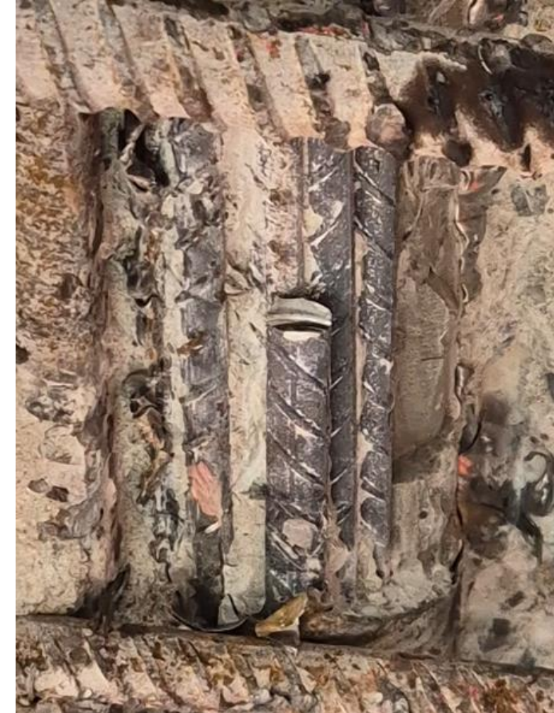
Durchtrennter Spanndraht
