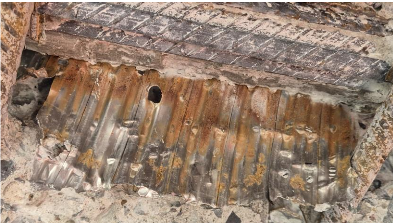
Korrosion Hüllrohrinnenseite
