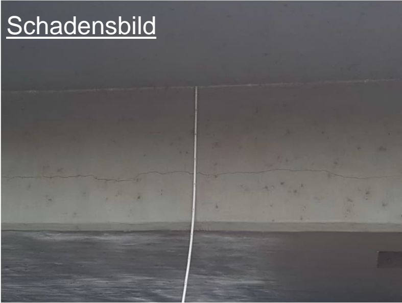
qualitativer Rissverlauf durch Steg
